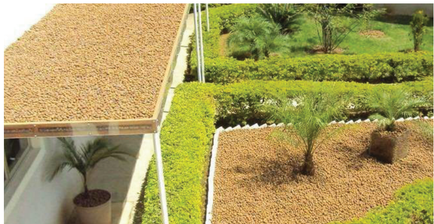
Img 31. Utilização de argila expandida sobre laje.
