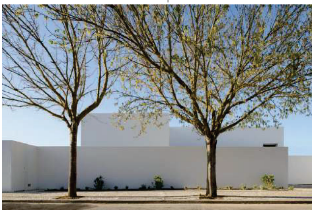
Img 15. Casa Oeiras.
