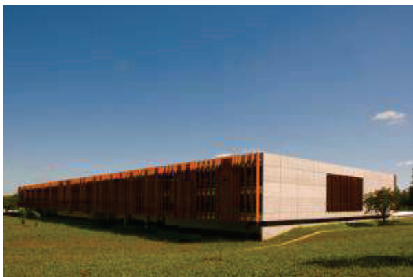
Img 09. Edifício dos escritórios.
