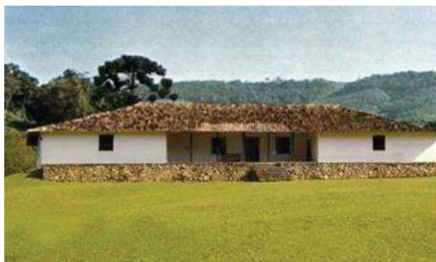
Img 27. Casa do Sítio Santo Antônio, São Roque-SP.
