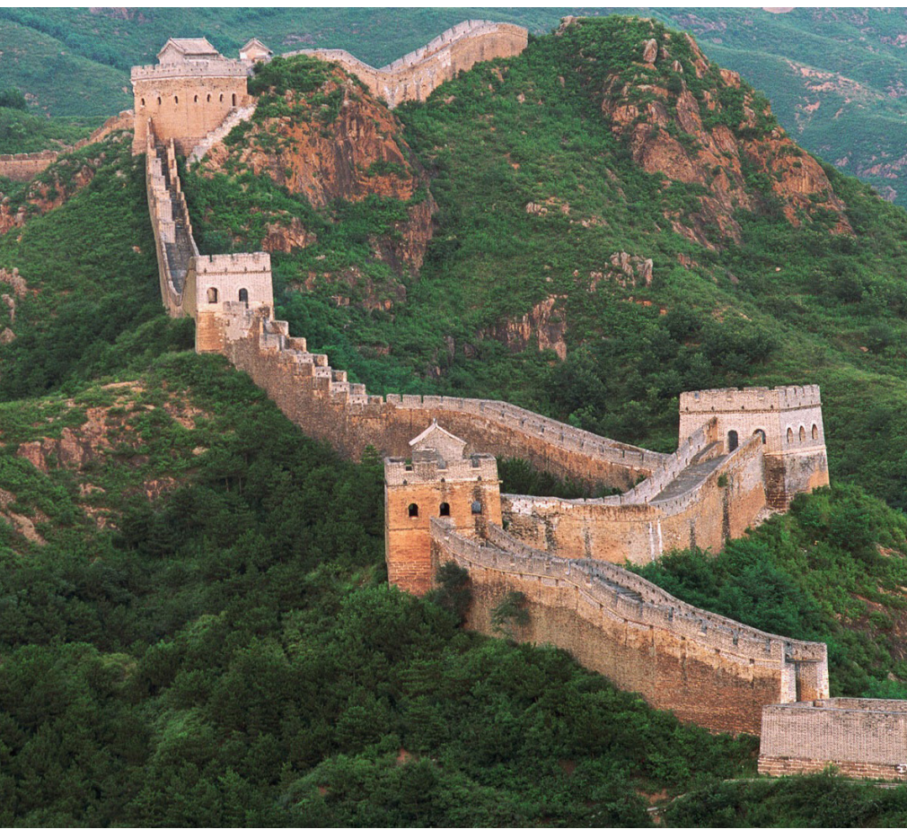
figura 14: A Grande Muralha da China que foi construída grandes porções com taipa. Fonte: https://www.todoestudo.com.br/wp-content/uploads/2018/01/Muralha-da-China.jpg
