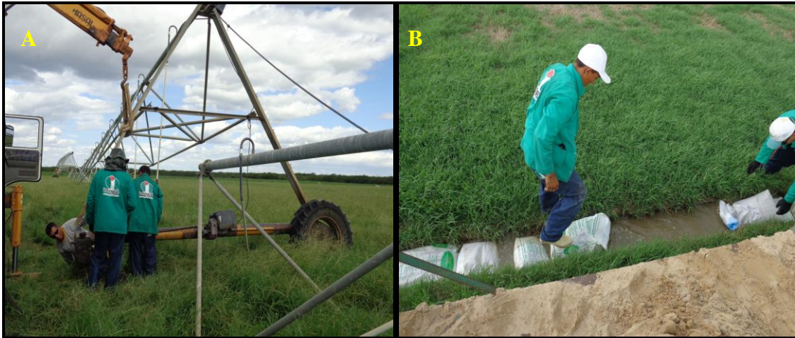
Figura 18 - Manutenção feito no pivô pequeno (A); Tampando os buracos no rastro do pivô (B)
