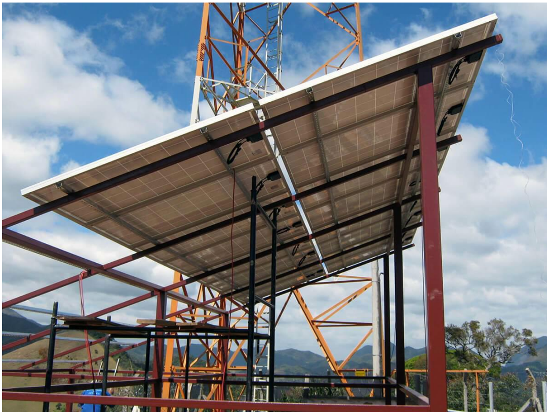
Figura 11: Instalação de Painéis Solares para Alimentação de ERBs
