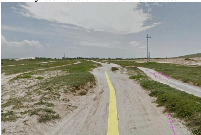
Figura 58 – Postes de média tensão em Jericoacoara.
