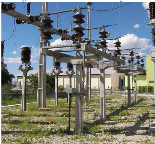
Figura 18 – Chaves seccionadoras tripolares.
