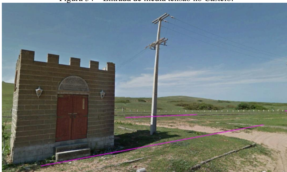
Figura 34 – Entrada de média tensão no Castelo.
