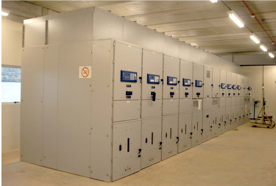
Figura 2.1 - Subestação abrigada.
