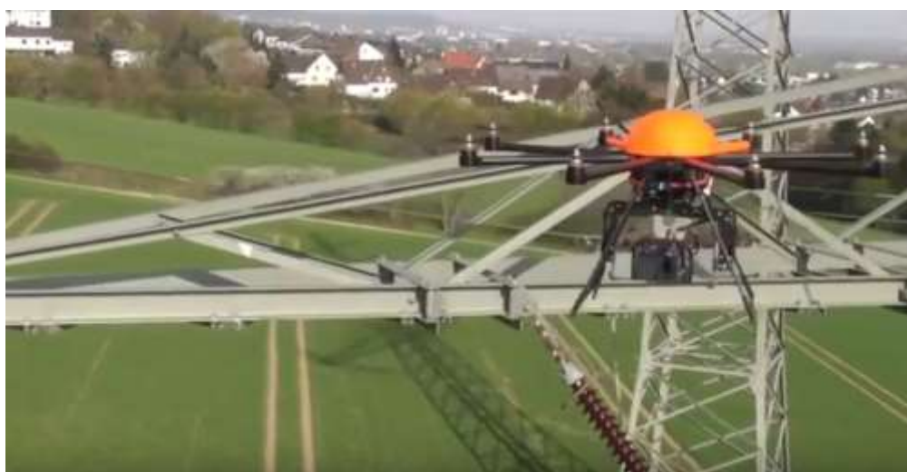
Figura 40 - Uso de drone em Inspeção
