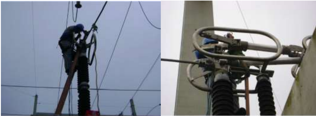
Figura 39 - Técnico da CEEE corrigindo a anomalia.
