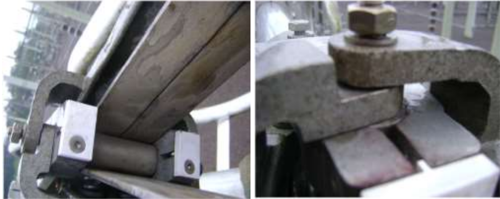
Figura 38 - Parafuso de regulagem
