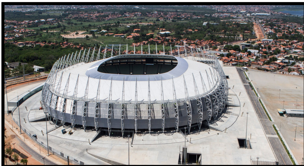
Figura 2. Estádio Castelão após as obras objeto da PPP.
