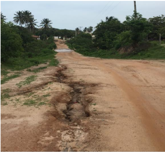
Figura 6 – Estradas dentro do Assentamento Maceió
