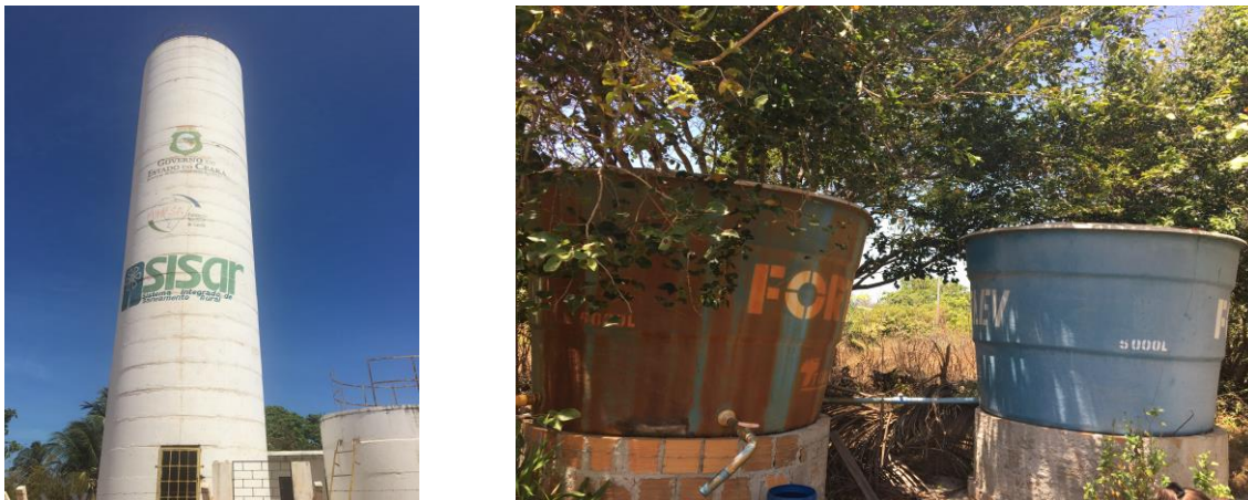
Figura 10 – Reservatório de água da SISAR e Caixas d'água.
