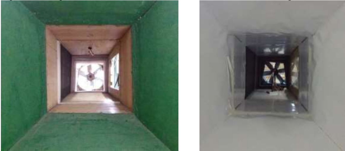
Figura 12 - Progresso de revestimento interno do Túnel de vento: antes e depois
