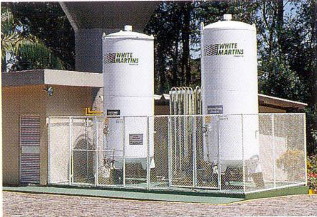
Figura 20 – Instalação padrão de ar medicinal sintético
