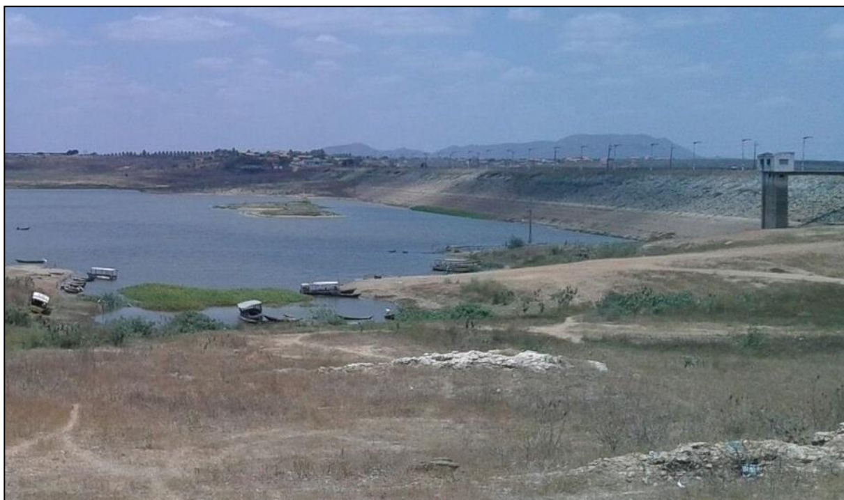
Figura 1 – Reservatório Pereira de Miranda.
