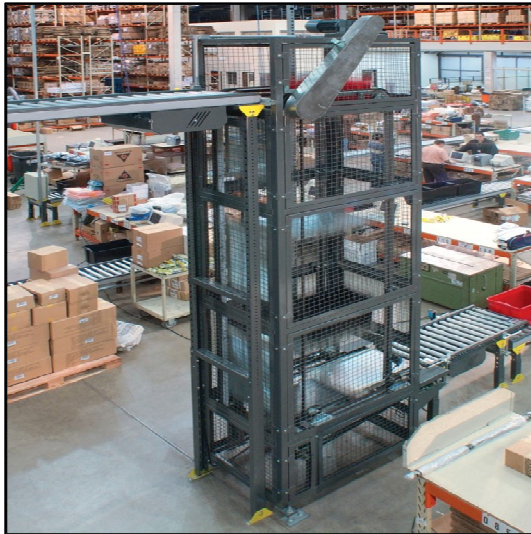
Figura 15 – Elevador de cargas
