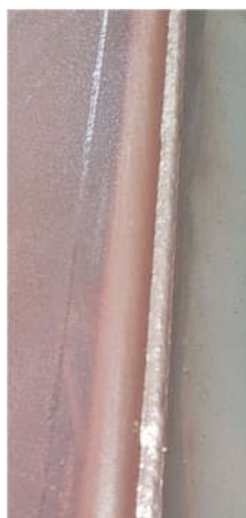
Figura 32 - Cordões de solda na junta sobreposta com arame tubular (E01)
