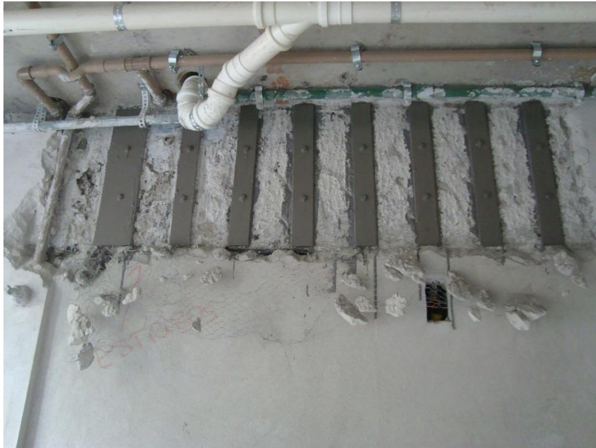
Figura 2 - Reforço em viga utilizando chapas de aço aderidas ao concreto
