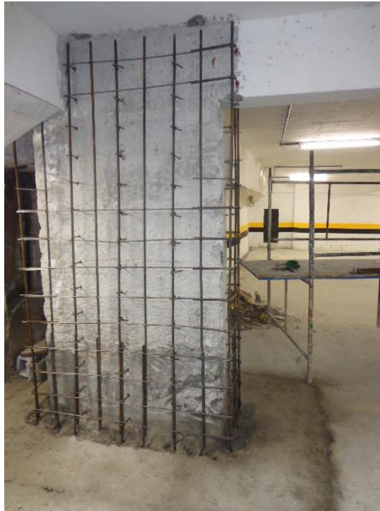
Figura 1 - Aumento da seção resistente de um pilar
