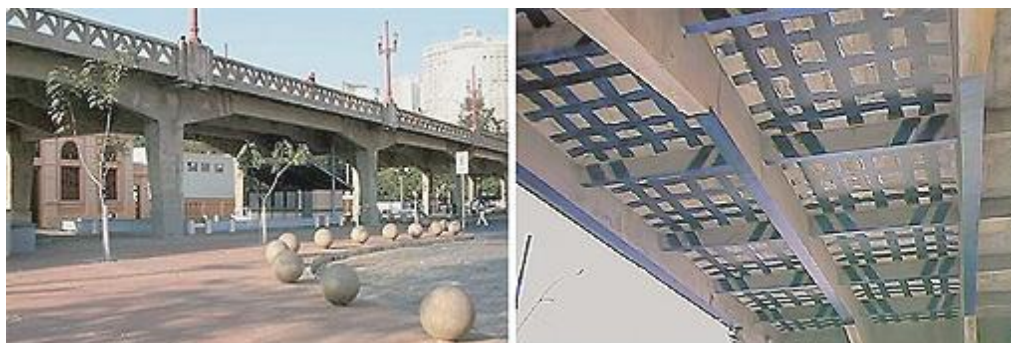
Figura 5 - Reforço com fibra de carbono no Viaduto de Santa Teresa
