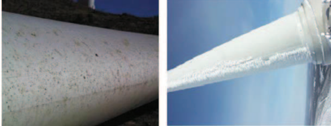
Figura 18 - Rugosidades causadas por acúmulo de insetos e gelo
