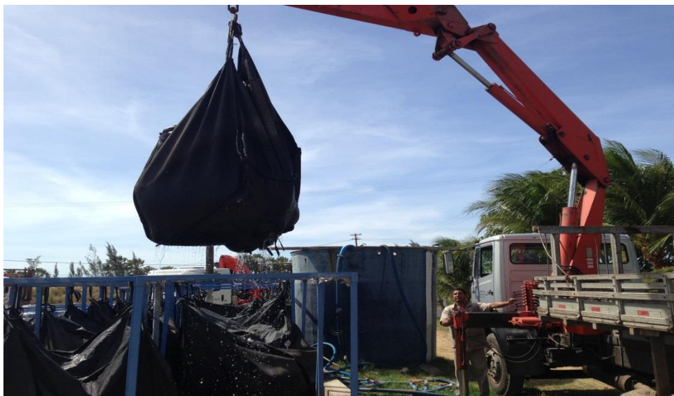
Figura 5 – Transporte do lodo retido nos sacos para a Fazenda Mastruz Com Leite em Pentecoste – CE.
