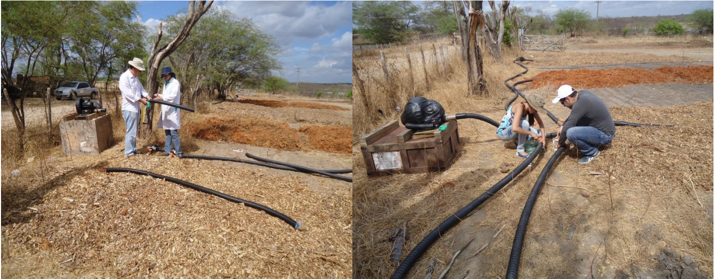
Figura 7 – Montagem do sistema de aeração por aerogeradores.
