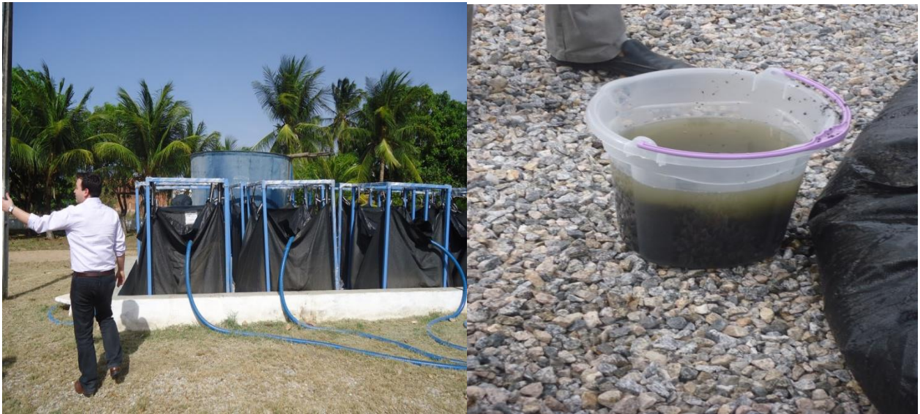
Figura 4 – Sistema de chicanas antes dos sacos e mistura de lodo e polímero em processo de floculação.
