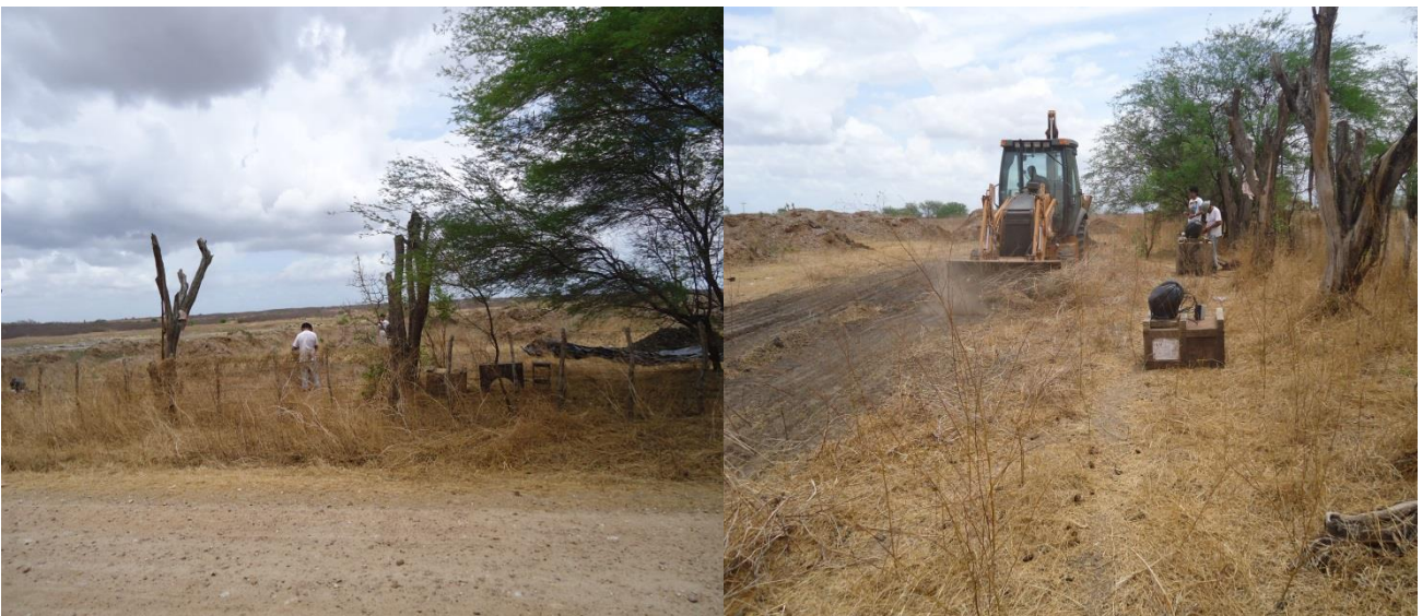
Figura 13 – Limpeza da área experimental destinada à compostagem na Fazenda Mastruz Com Leite, Pentecoste – CE.
