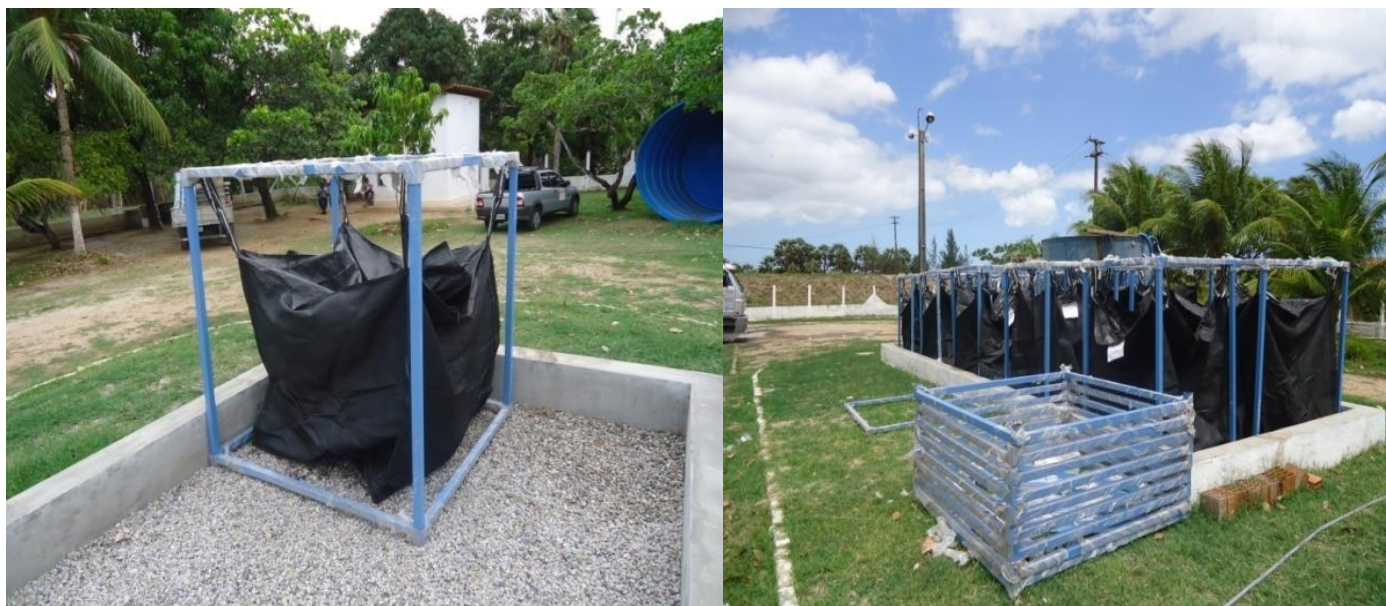
Figura 2 – Estrutura utilizada no deságue do lodo séptico na ETE Metr pole, Caucaia - CE
