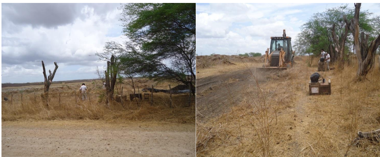
Figura 6 – Limpeza da área experimental destinada à compostagem na Fazenda Mastruz Com Leite, Pentecoste – CE.
