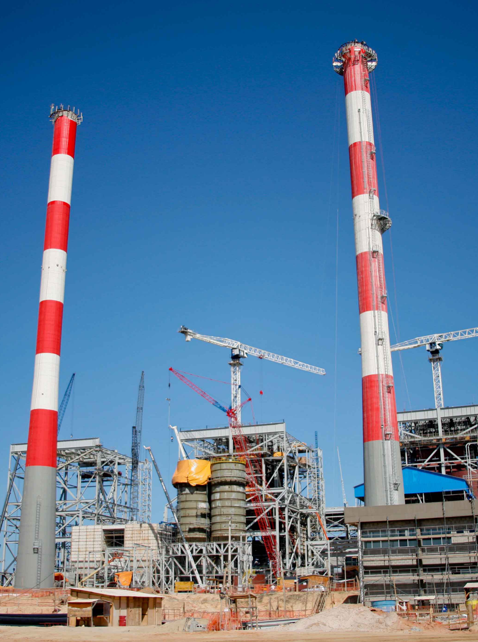
Chaminés de duas das três unidades das usinas Energia Pecém e MPX Pecém II (FOTO: DIVULGAÇÃO)
