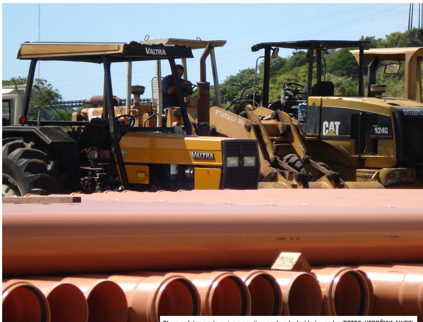
Obras no loteamento seguem em ritmo acelerado devido às vendas (FOTOS: HERBÊNIA ALVES)
