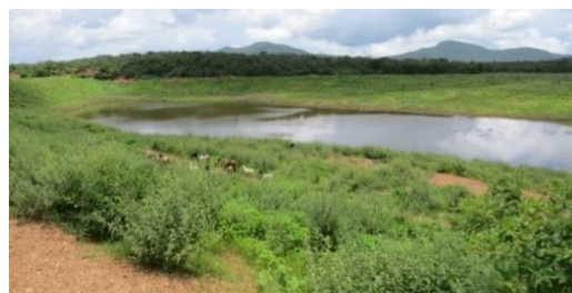
Açude quinze (Próximo à Jazida)
