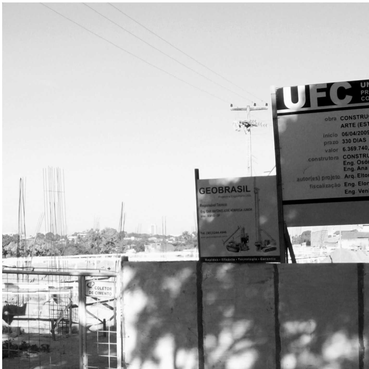
» CANTEIRO DE OBRAS do que será a sede do Instituto de Cultura e Arte, fotografado em julho deste ano. Detalhe para o início da obra e o prazo.
