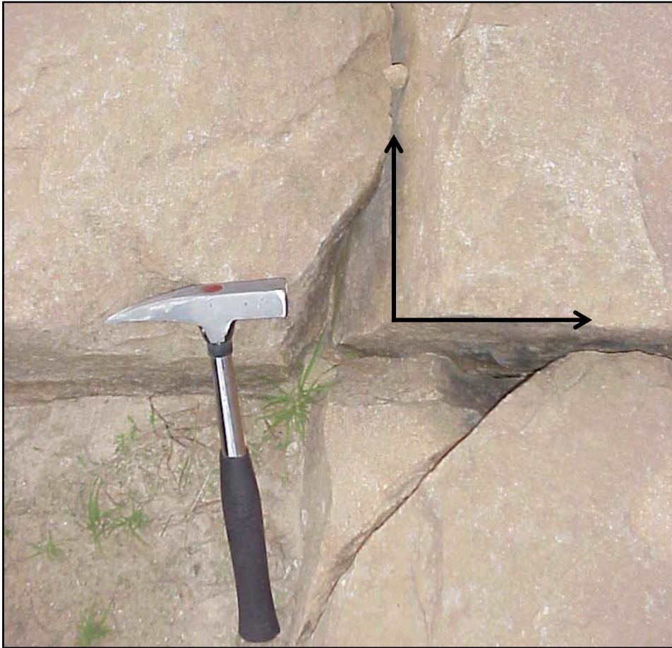
Figura 3.9 - Afloramento do arenito Serra Grande, próximo ao açude Jaburu I, mostrando o sistema de fraturas ortogonais e o grau de silicificação dos blocos da matriz arenítica.
