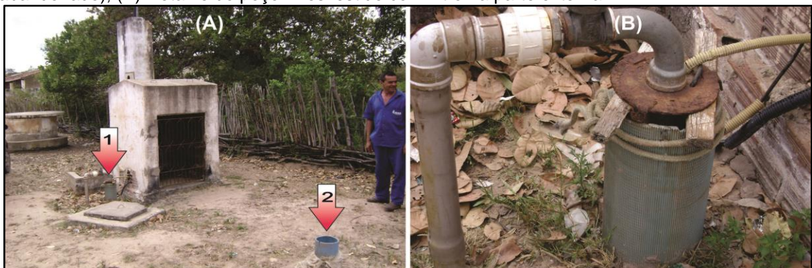
Figura 9.2 - Vista geral de captação em Ipaporanga. (A) Disposição dos poços 1 (produtor) e 2 (abandonado); (B) Detalhe do poço 1 revestido com filtro na parte externa.
