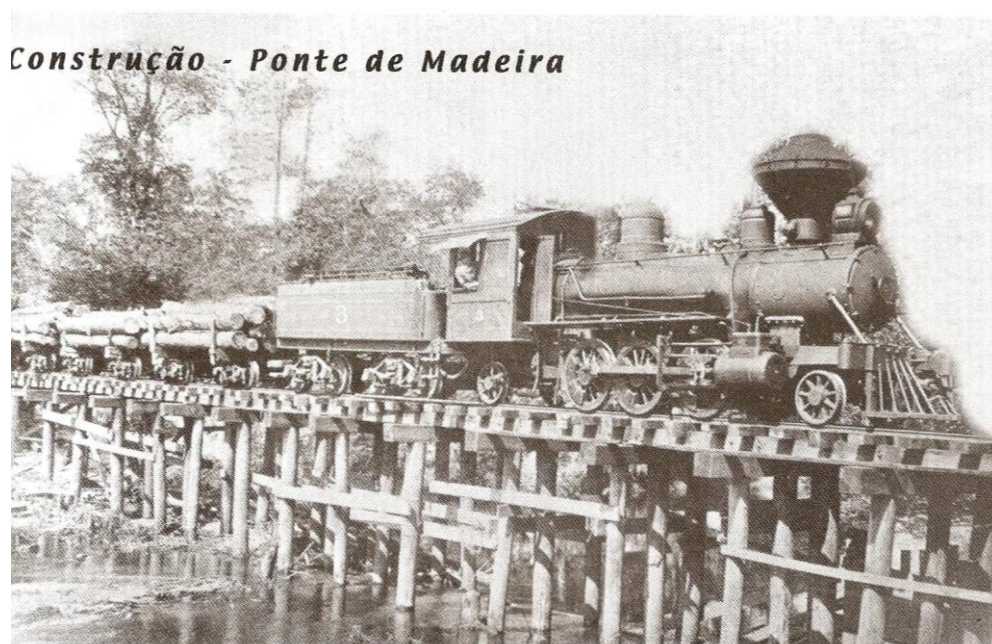
Imagem 8: Ponte de madeira na EFB – sem data. 564
