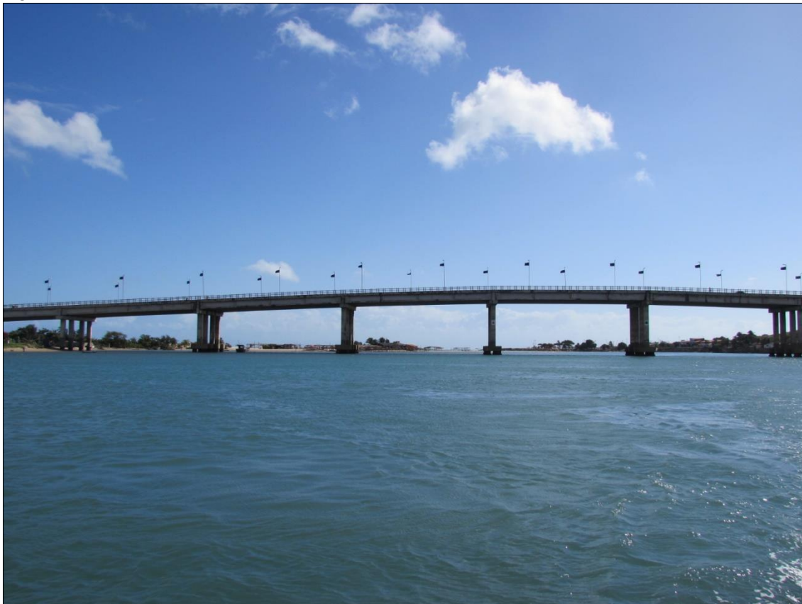
Figura 8 – Ponte sobre o Rio Ceará.
