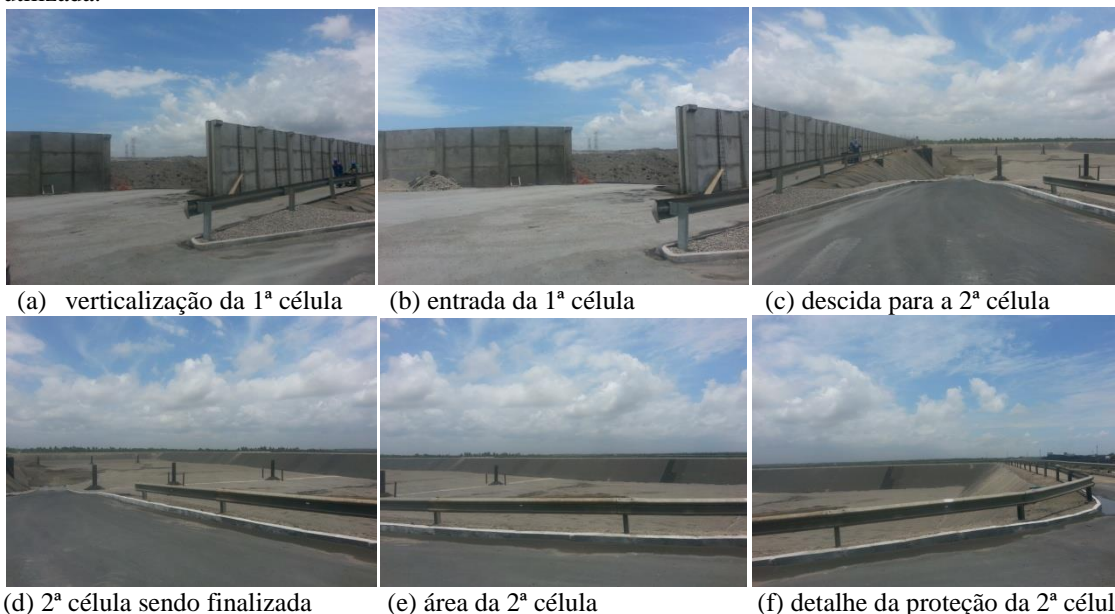
Figura 9 - Verticalização da 1ª célula de armazenamento de cinzas da termelétrica e 2ª célula ainda não utilizada.
