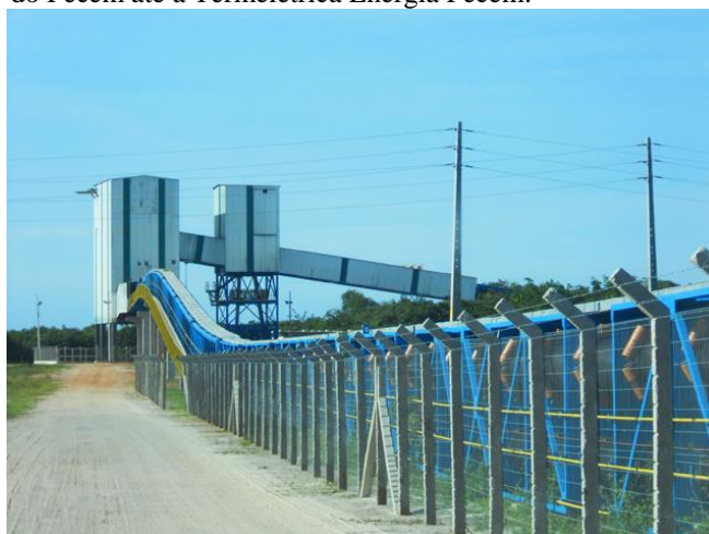
Figura 5 - Esteira transportadora de carvão instalada do Porto do Pecém até a Termelétrica Energia Pecém.
