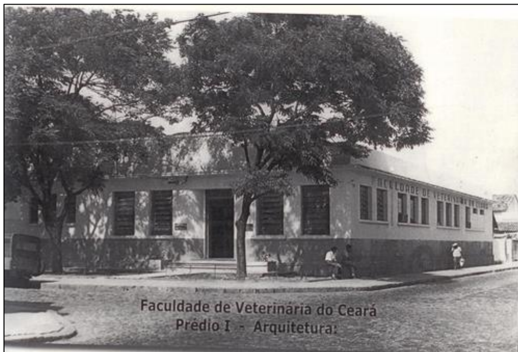
Figura 3 – Primeiro prédio onde funcionou a Faculdade de Veterinária do Ceará, entre as ruas Princesa Isabel e Clarindo de Queiroz.
