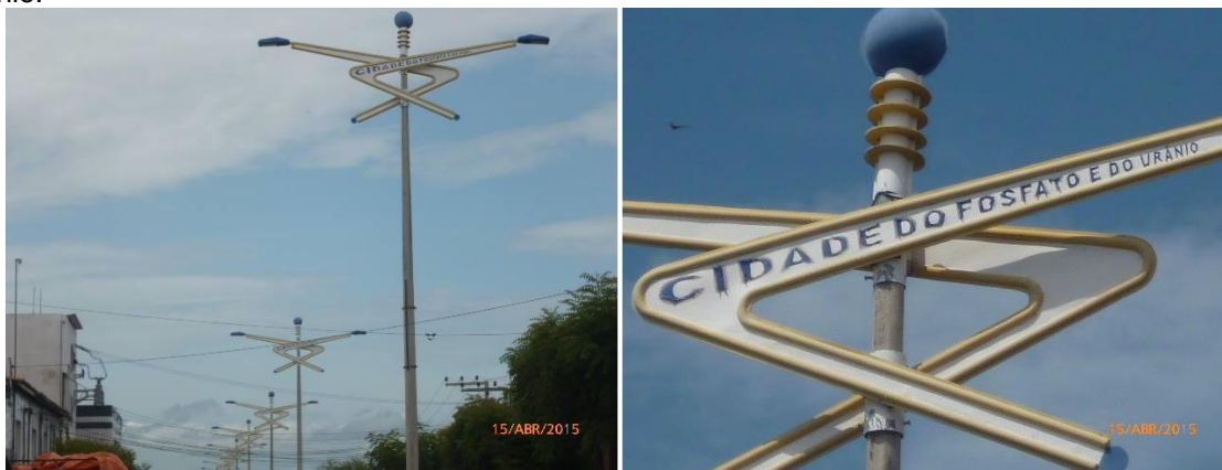
Figura 3 – Postes de iluminação na sede do município de Santa Quitéria propagando o fosfato de urânio.
