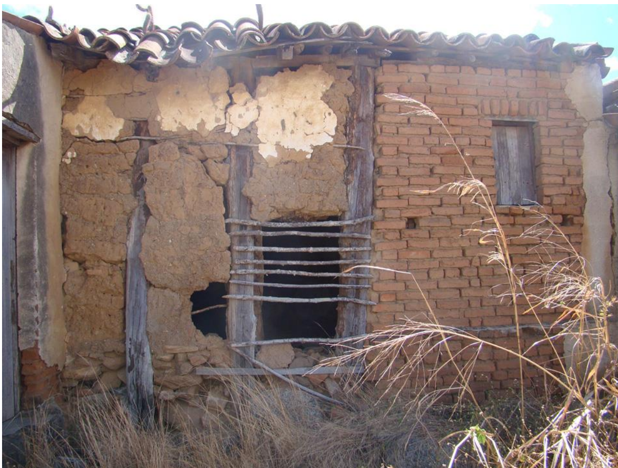
Figura 04. Detalhe do sistema construtivo paredes externas. Fachada posterior. Casa do Umbuzeiro – Aiuaba – Século XVIII. Foto: Clovis Jucá.
