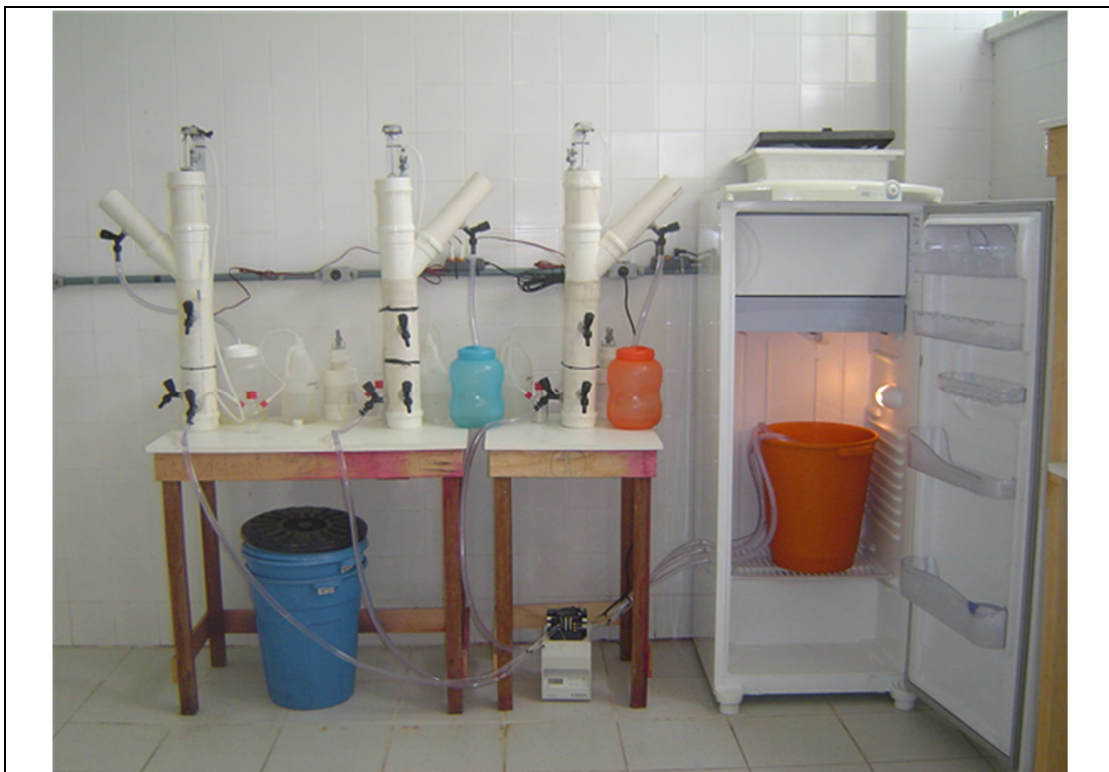
Figura 7 – Conjunto de reatores UASB usados na inoculação e na avaliação inicial do lodo anaeróbio utilizado neste estudo
