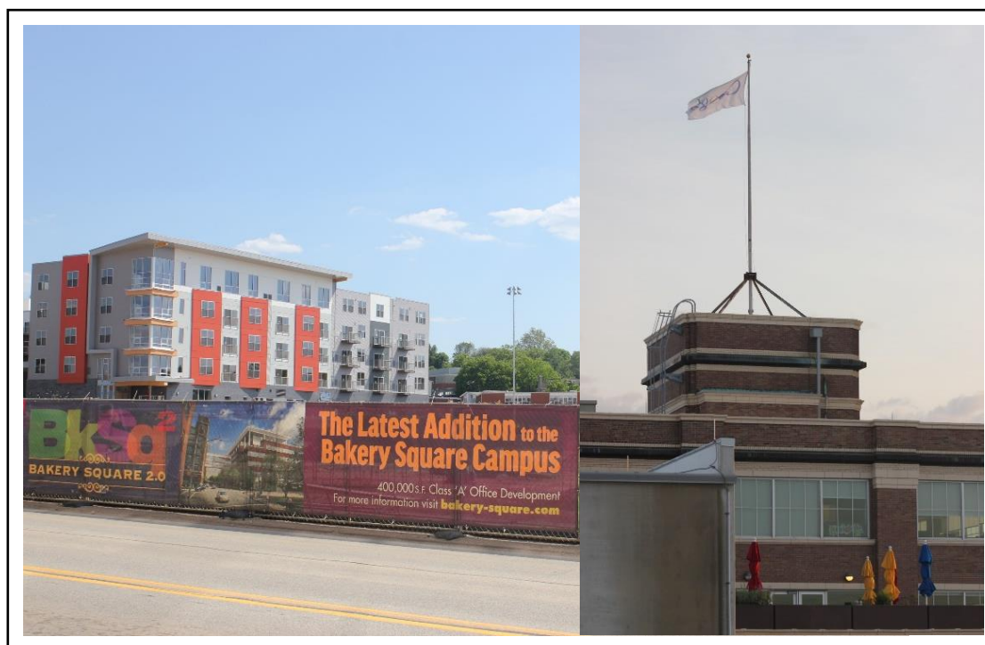
Figura 26 - GooglePlex em Pittsburgh e o Bakery Square 2.0
