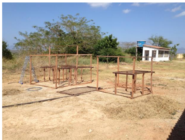
Figura 2. Construção do telados no IFCE-Campus Umirim.
