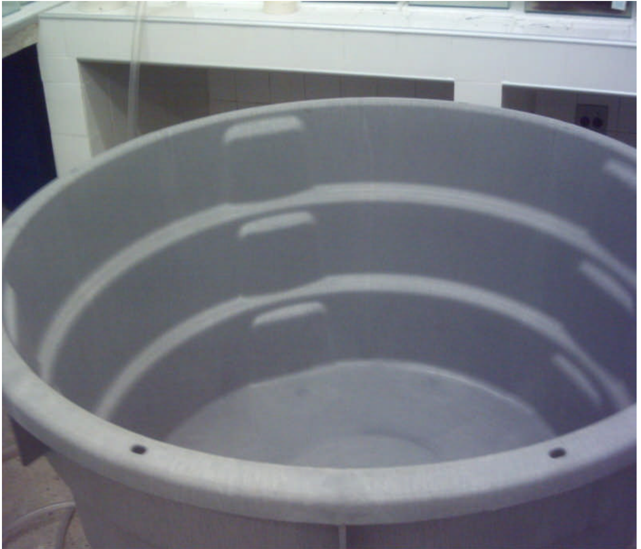
Figura 2 – Tanque de homogeneização das águas dos efluentes.
