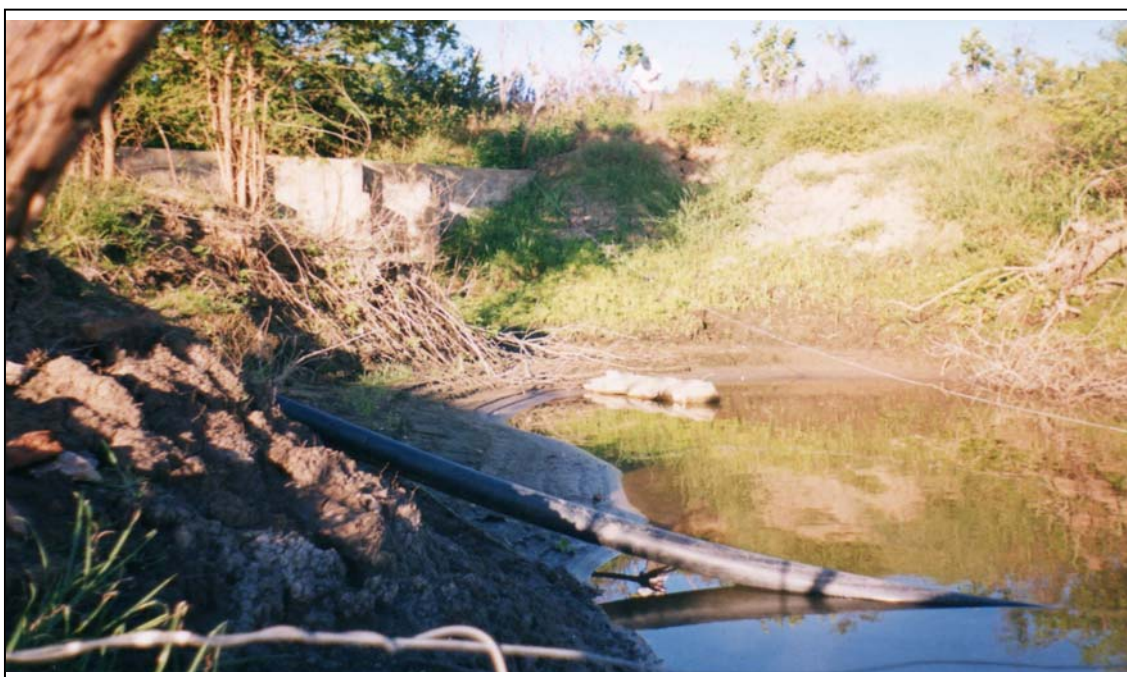
Foto 8. Fonte de captação e despejo de água no Rio Jaguaribe
