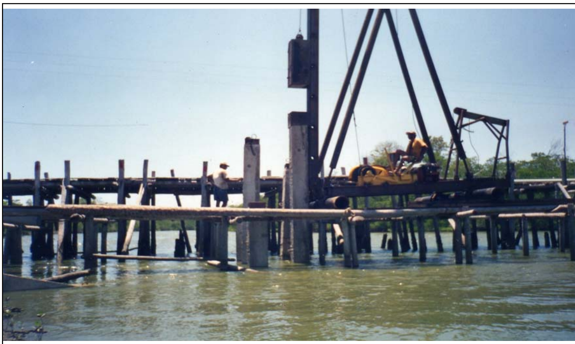
Foto 5. Construção de Ponte de acesso ao Cumbe
