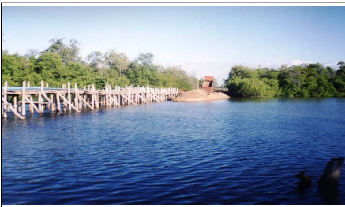
Foto 6. Ponte sobre o Rio Jaguaribe liga Canaveira/Cumbe
