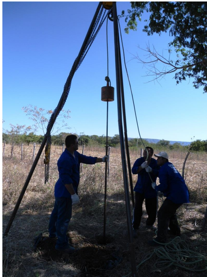
Figura 6 - Sondagens a percussão realizadas na área da aluvião
