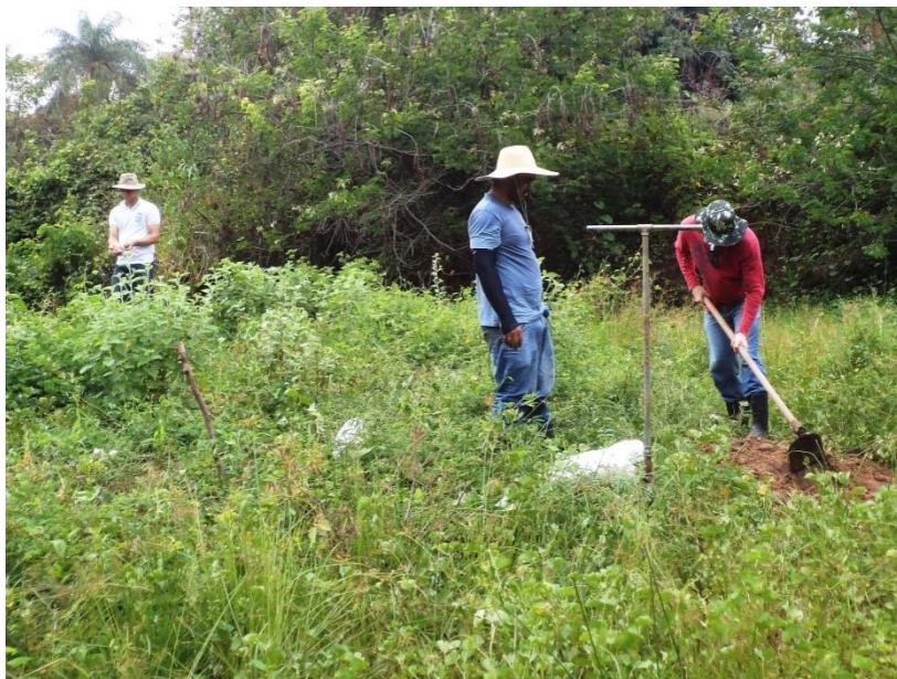
Figura 11 - Sondagem realizada para caracterização do material do leito do riacho
