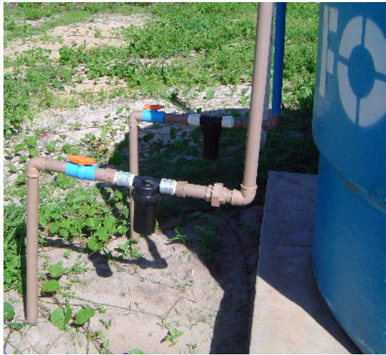
FOTO 6 – Filtros instalados antes do reservatório de água.
