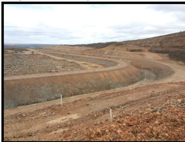
Fotografia 15 – Construção do CAC - Trecho 1
