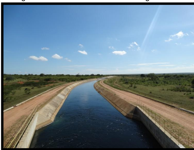
Fotografia 13 – Trecho I do Eixão das Águas
