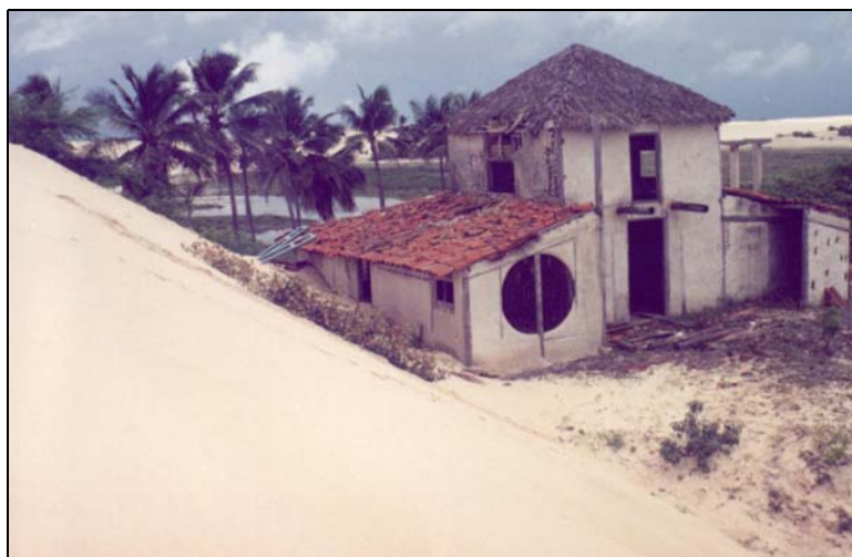
Figura 05 – Algumas construções edificadas mais próximas às dunas estão sendo soterradas. Foto: Projeto Canoa, agosto de 2002.
