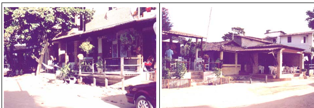
Figura 31– Construção de sacadas, escadas e jardineiras invadindo o espaço público da rua e da propriedade vizinha, reduzindo a caixa de passagem da via para veículos e eliminado a possibilidade de construção de calçadas para pedestres. (Fotos da autora, agosto de 2002)
