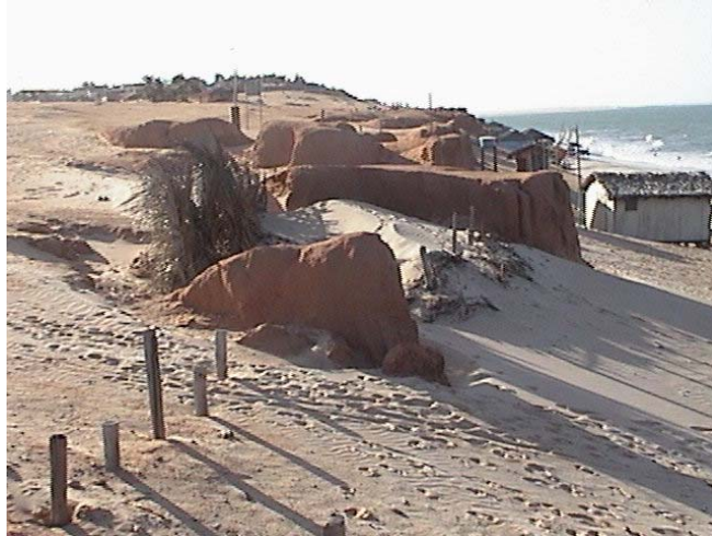
Figura 20 – Tentativas paliativas de contenção das areias que invadem o povoado através das fendas das falésias provocadas por erosão.
