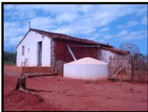
FIGURA 44: Casa com cisterna construída pelo INCRA – Facundo III
