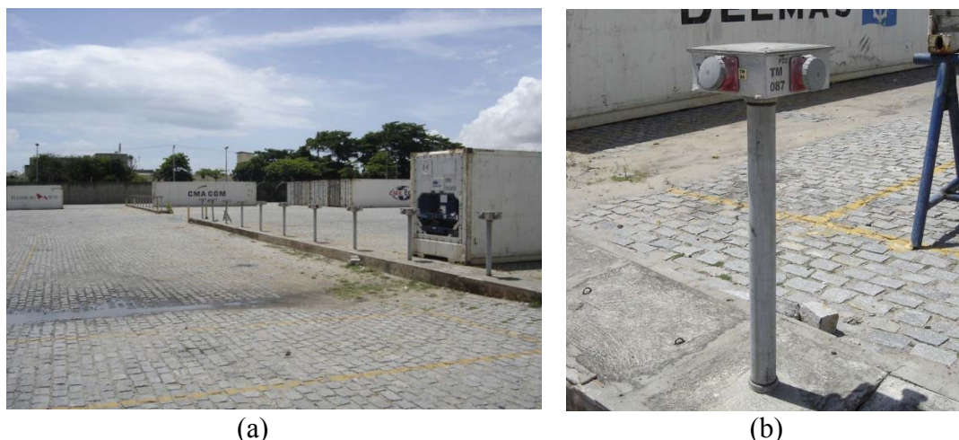
Figura 3.3 – (a) Pátio para contêineres reefer do Porto de Fortaleza em 2008 e (b) Plugs para contêineres reefer do Porto de Fortaleza em 2008
