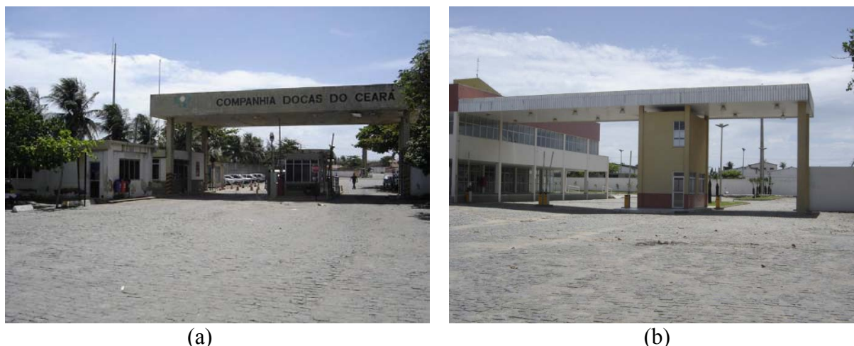
Figura 3.1 – (a) Portão para entrada e saída de veículos do Porto de Fortaleza até o início de 2008 e (b) Novo Portão para entrada e saída de veículos do Porto de Fortaleza a partir de julho de 2008
