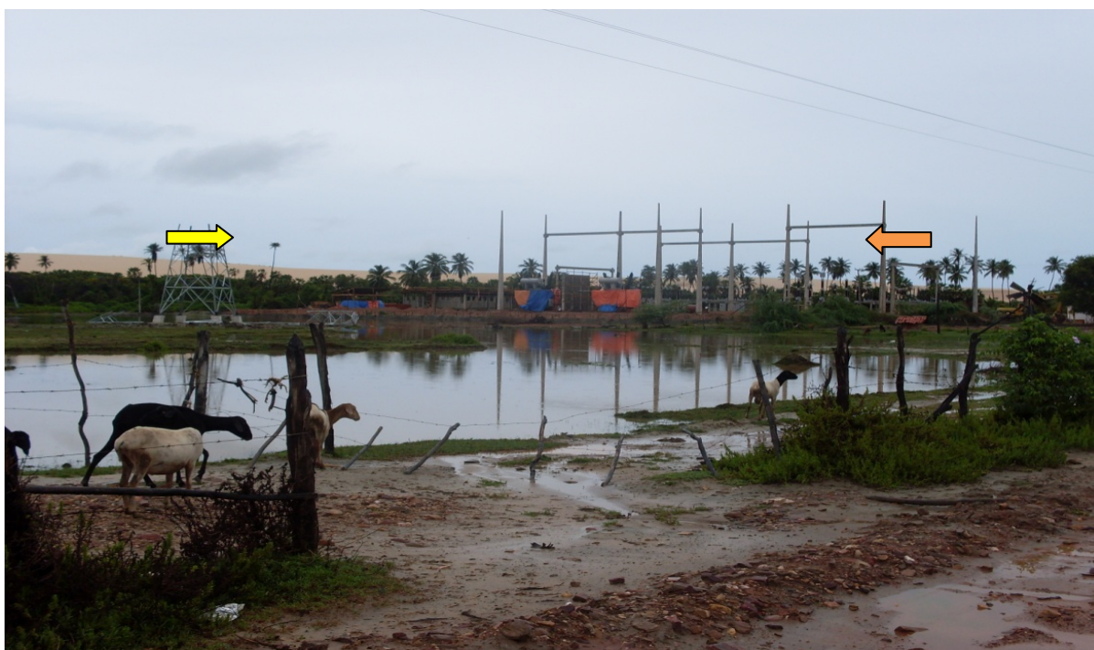
Figura 37 - Instalação da subestação (seta laranja) de energia eólica e da torre de transmissão de energia eólica (seta cor amarela) no Cumbe.
