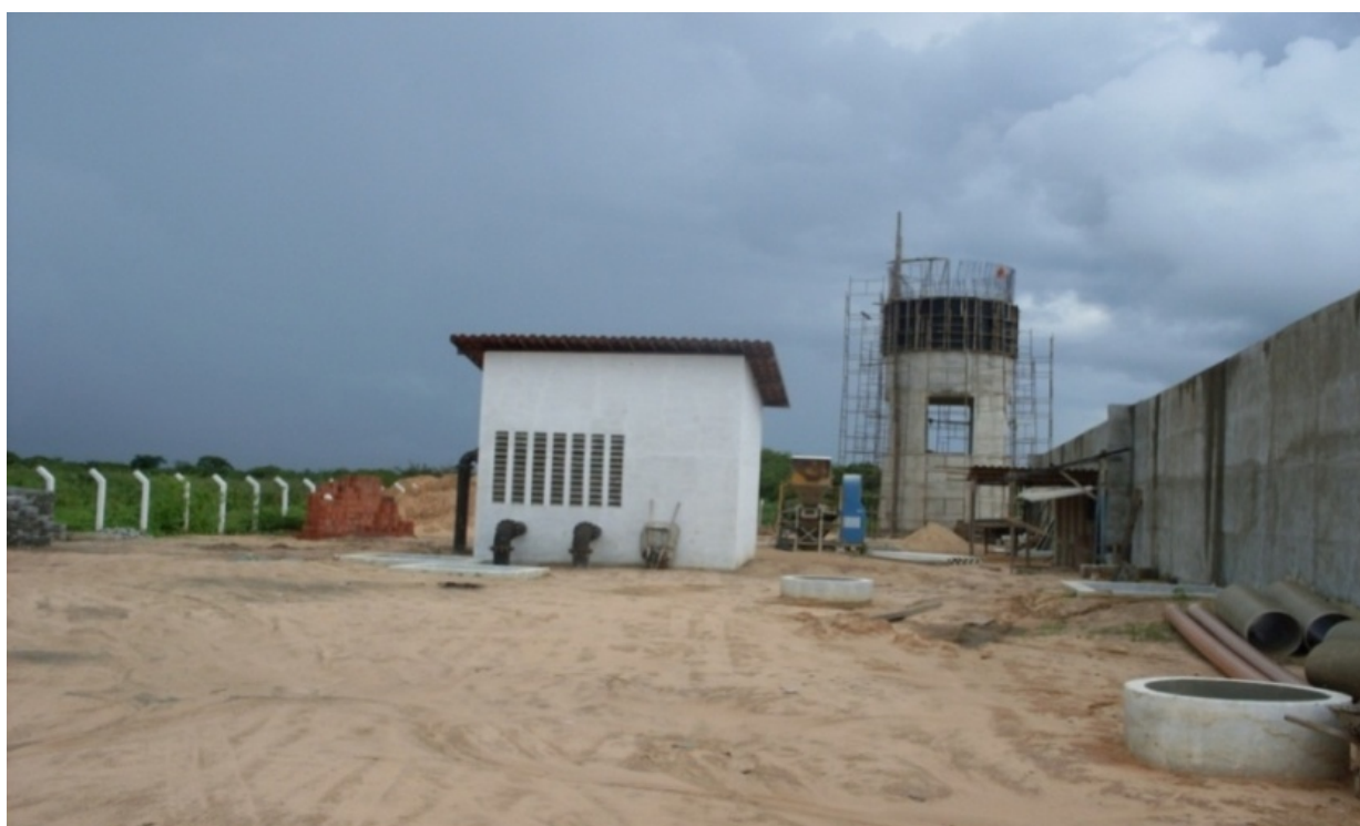
Figura 52 - Construção da nova unidade de tratamento de água e esgoto do Aracati
