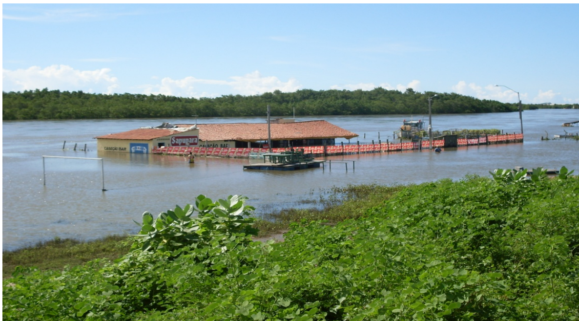
Figura 22 - Empreendimento no dique abandonado após a cheia do rio Jaguaribe
