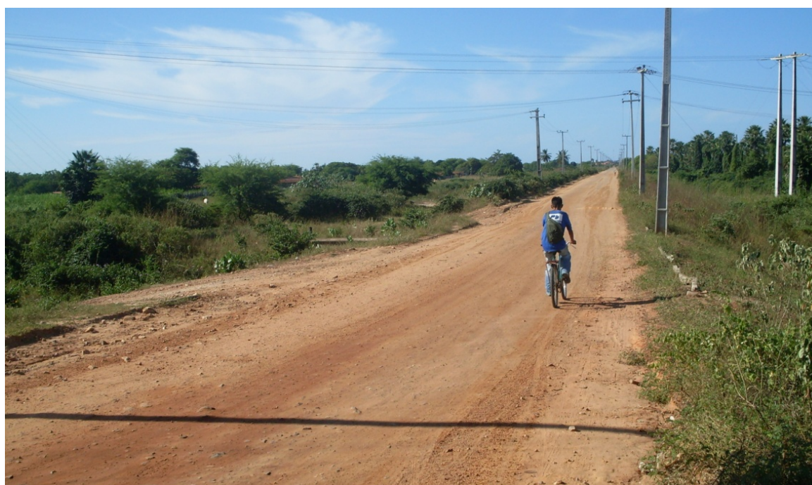
Figura 20 - Dique construído em 1985 para conter as enchentes na cidade
