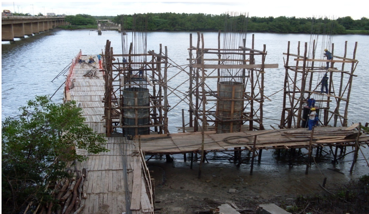
Figura 30 - Obras de duplicação e restauração da ponte JK.
