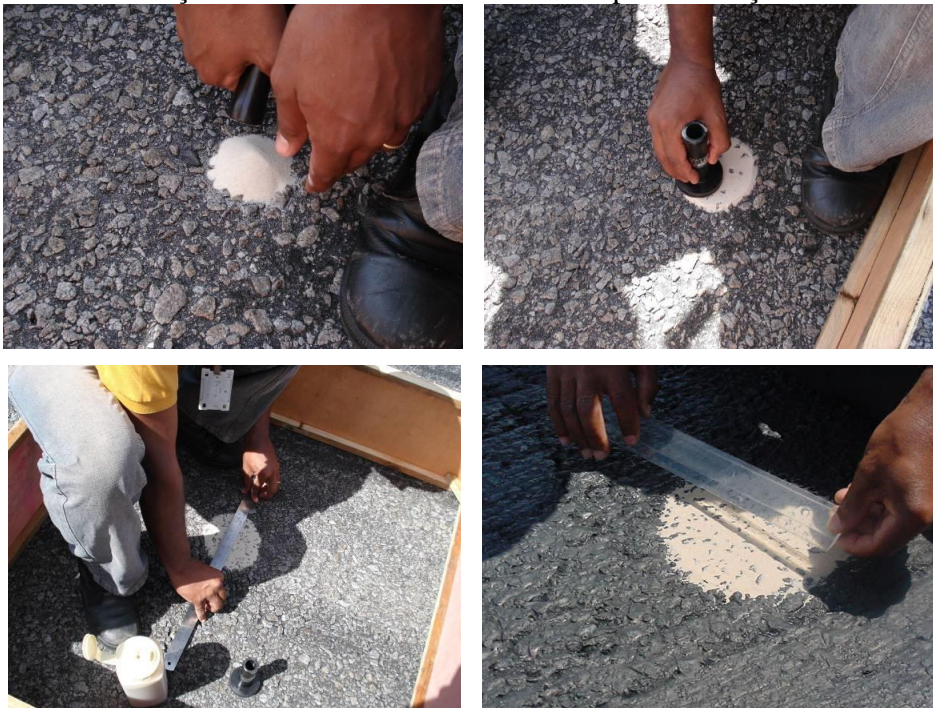
Figura 15 – Execução do ensaio de mancha de areia para obtenção da macrotextura.
