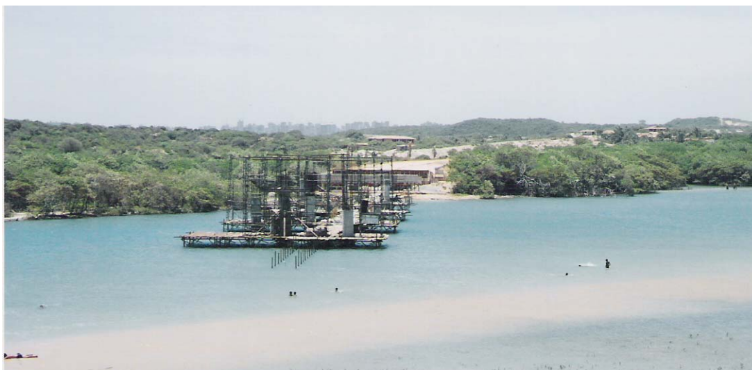
Imagem nº 39 Construção da ponte sobre o rio Cocó – 2003 Fonte: Mary Andrade
