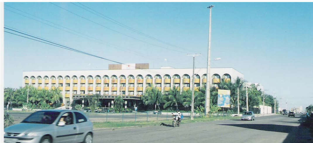
Imagem nº 8 Ocupação na faixa de pós-praia na Praia do Futuro – 2003
