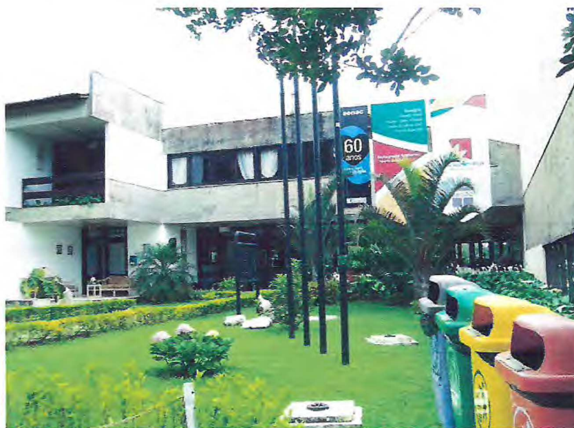
Figura 9 - Hotel Escola Senac Guaramiranga. Entrada da hospedagem. Fonte: Autor (2008)
