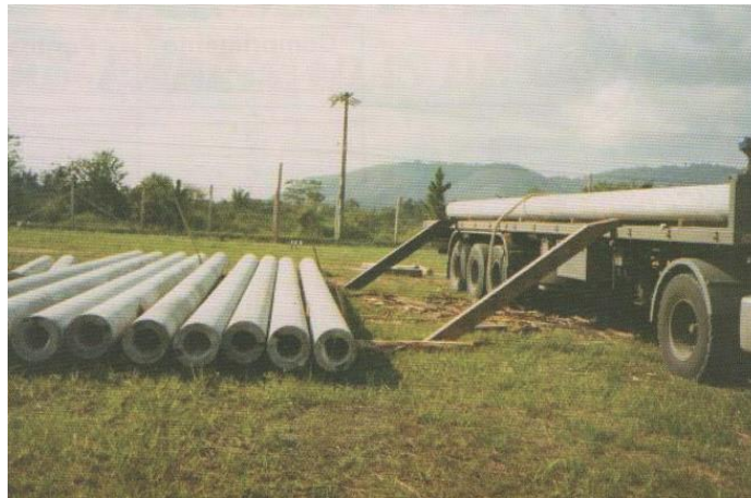
Figura 6 - Estacas descarregadas sem auxílio de guindastes.
