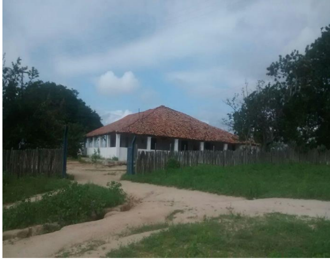
Figura 6 – A Casa sede / Casa grande
