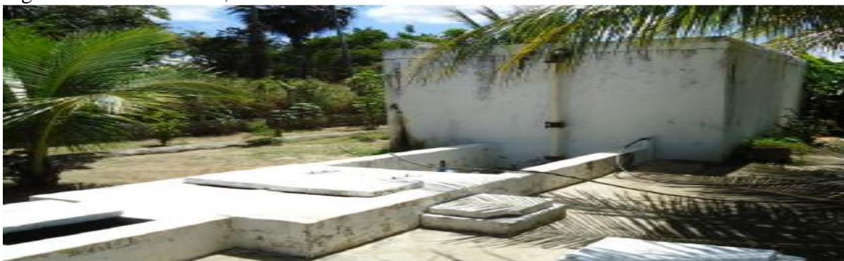
Figura 21 - ETE Sumaré, Fortaleza/Ce.
