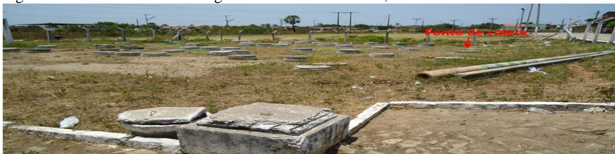
Figura 27 – Sistema Decanto-Digestor da ETE Nova Vida, Maracanaú-Ce.
