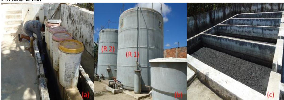
Figura 12 – (a) Calha parshall, (b) Reatores UASB, (c) Leitos de secagem da ETE Aracapé, Fortaleza/Ce.
