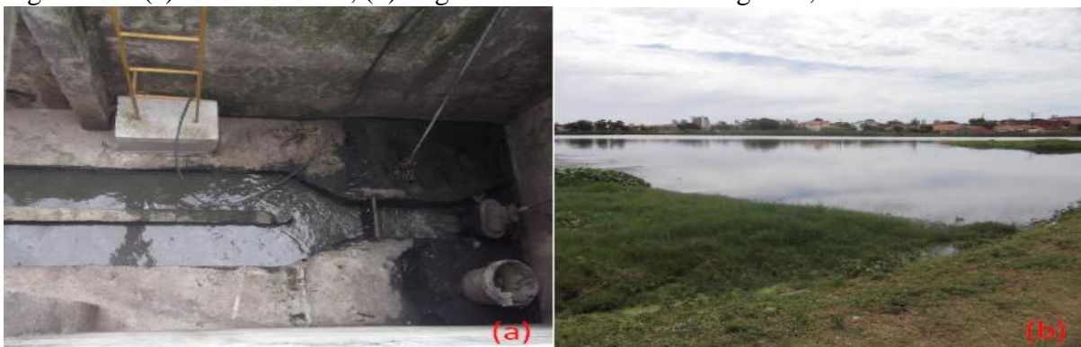
Figura 16 – (a) Calha Parshall, (b) Lagoa facultativa da ETE Lagamar, Fortaleza/Ce.
