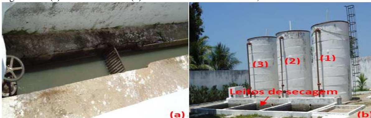
Figura 24 – (a) Calha Parshall e (b) Reatores da ETE Por do Sol, Fortaleza/Ce.
