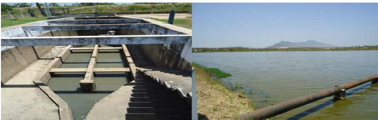
Figura 34 – (a) calha parshall e (b) esquerda a lagoa facultativa da ETE Nova Metr pole, Caucaia/Ce.
