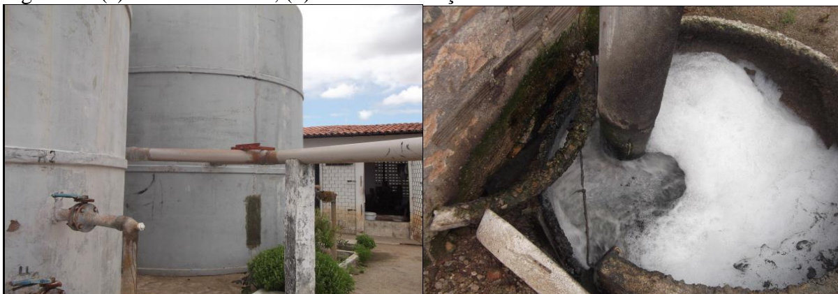
Figura 7 – (a) Reatores UASB, (b) Ponto de cloração da ETE Riacho Doce Fortaleza/Ce.
