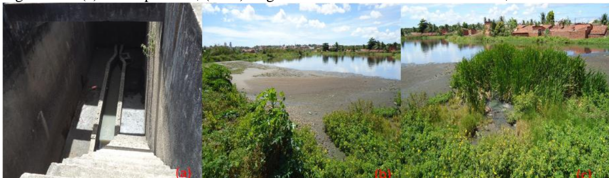
Figura 15 – (a) Calha parshall, (b e c) Lagoa facultativa da ETE João Paulo II, Fortaleza/Ce.
