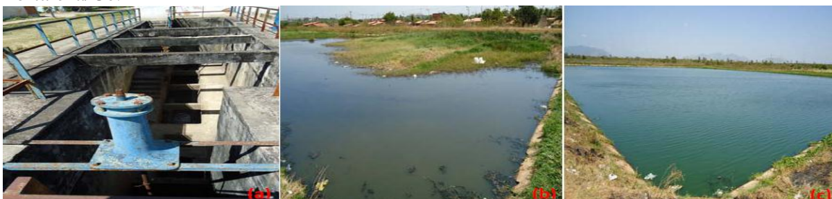
Figura 31 – (a) Calha parshall, (b) Lagoa anaeróbia, (c) Lagoa facultativa da ETE Palmeiras, Fortaleza/Ce.
