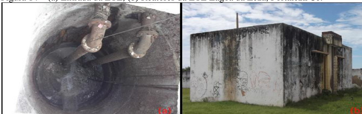
Figura 14 – (a) Entrada da ETE, (b) Reatores da ETE Lagoa da Zeza, Fortaleza/Ce.
