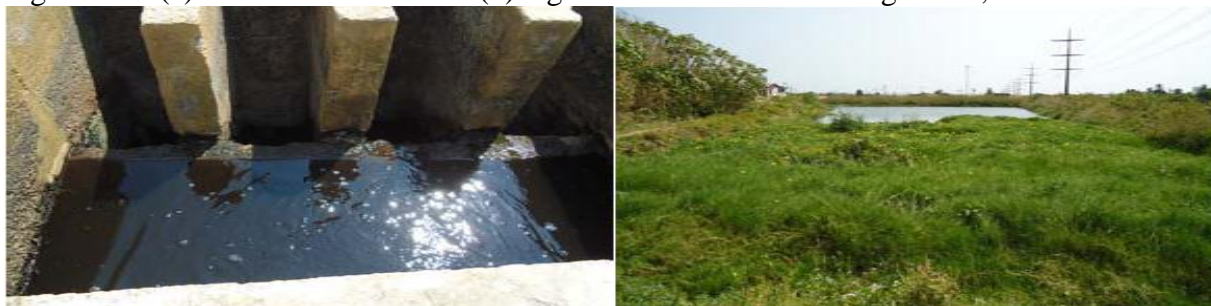
Figura 32 – (a) entrada do afluente e (b) lagoa anaeróbia da ETE Jangurussú, Fortaleza/Ce
