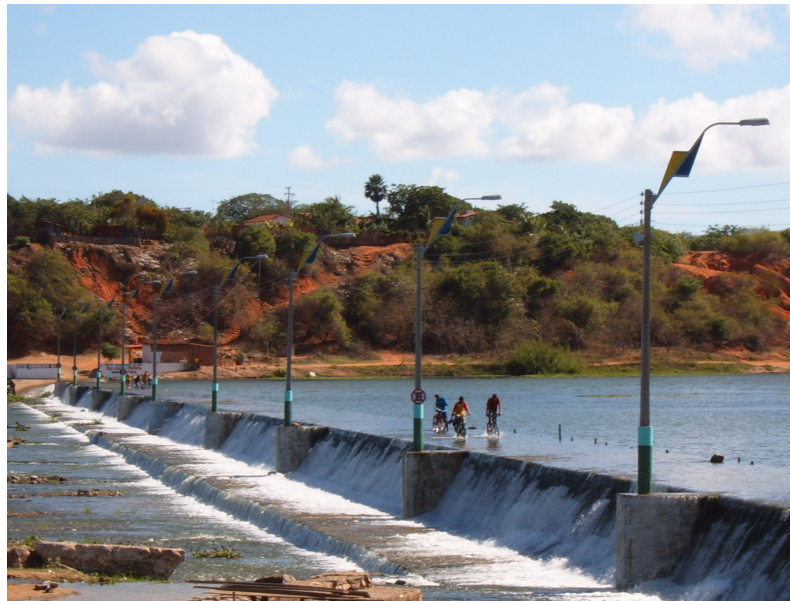
Figura 1.1.1 - Soleira construída na região de Itaiçaba (CE), para tomada de água para o canal do trabalhador, que em períodos de seca prolongada abastece a cidade de Fortaleza.
