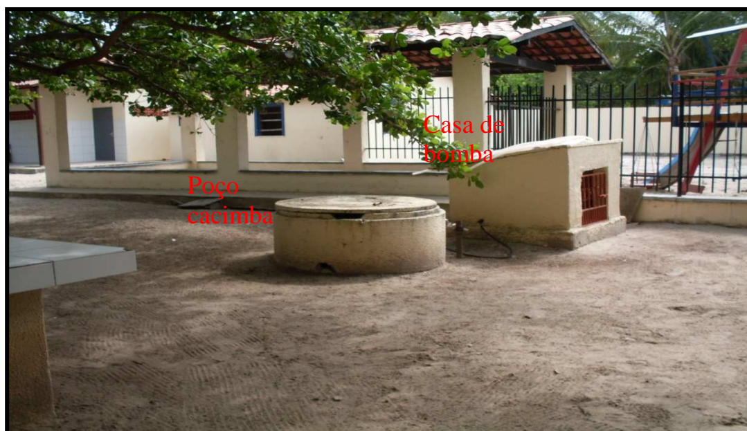
Foto 10- Poço 164, escavado, com profundidade de 10m, localizado na Escola Pública Plácido Castelo (Distrito Tapera), revestido com anel de cimento. (coord. 9563446 e 573035)
