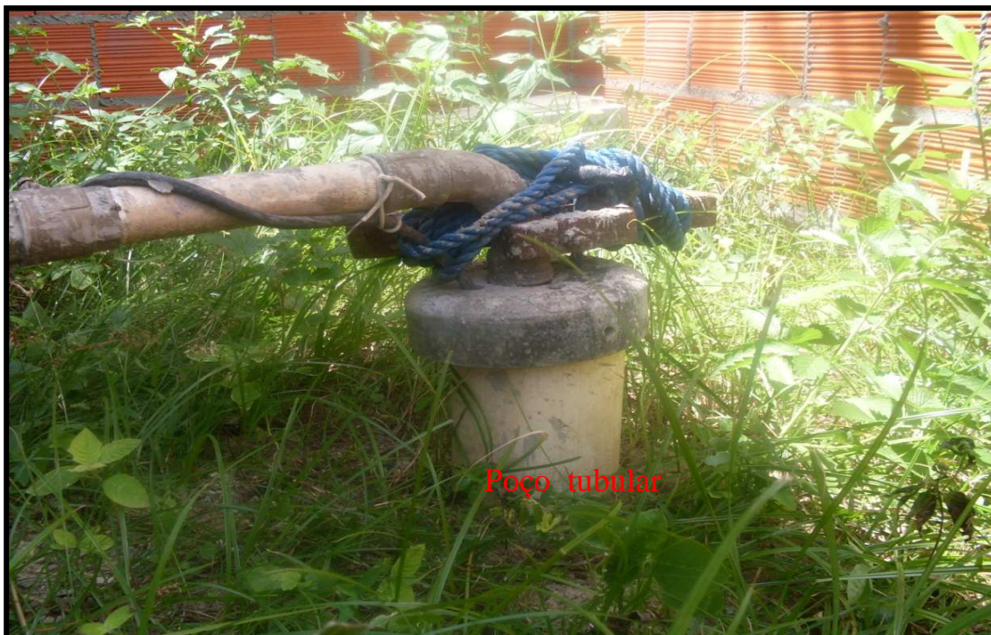
Foto 9 - Poço tubular revestido com PVC branco, pertencente ao chafariz da localidade de Canoa (Nº 41 no cadastro geral). (Coordenadas: 9564818 e 570677).
