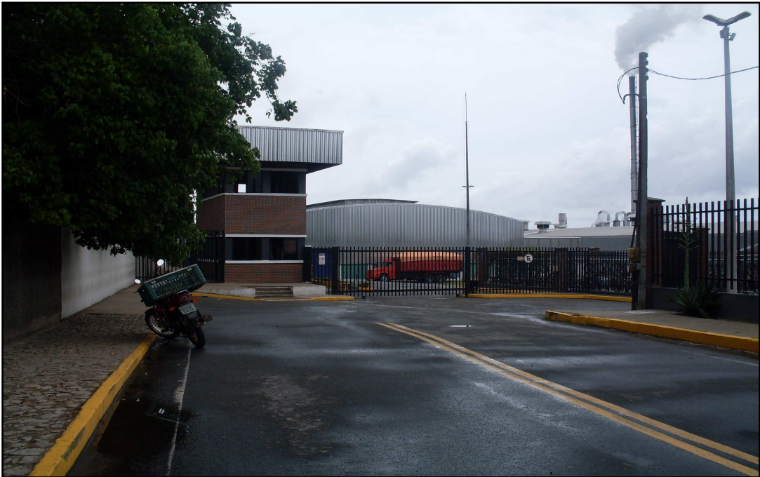
Foto 1 - Aspecto da usina de castanha USIBRAS, que usa água subterrânea e superficial da lagoa do Catu, localizada em Aquiraz, à margem da CE-040. Coord.: 9566066/568426 (março/2012)
