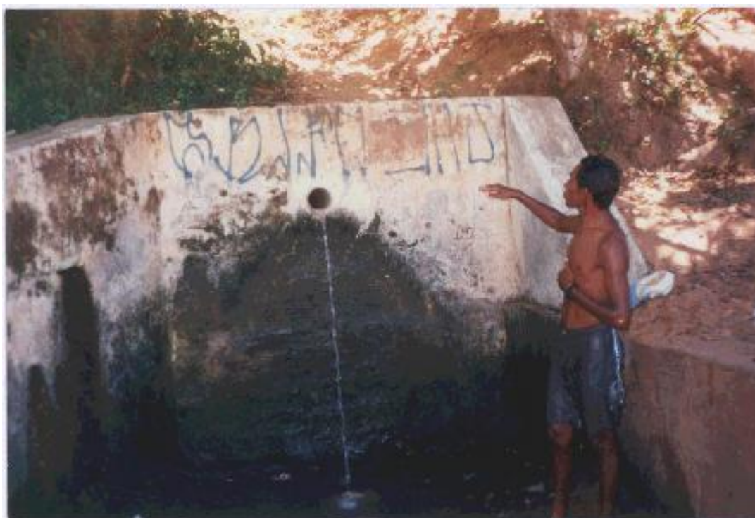
Foto 5 – Fonte do Iguape: Alternativa de abastecimento por água subterrânea (Sistema aquífero dunas/paleodunas)
