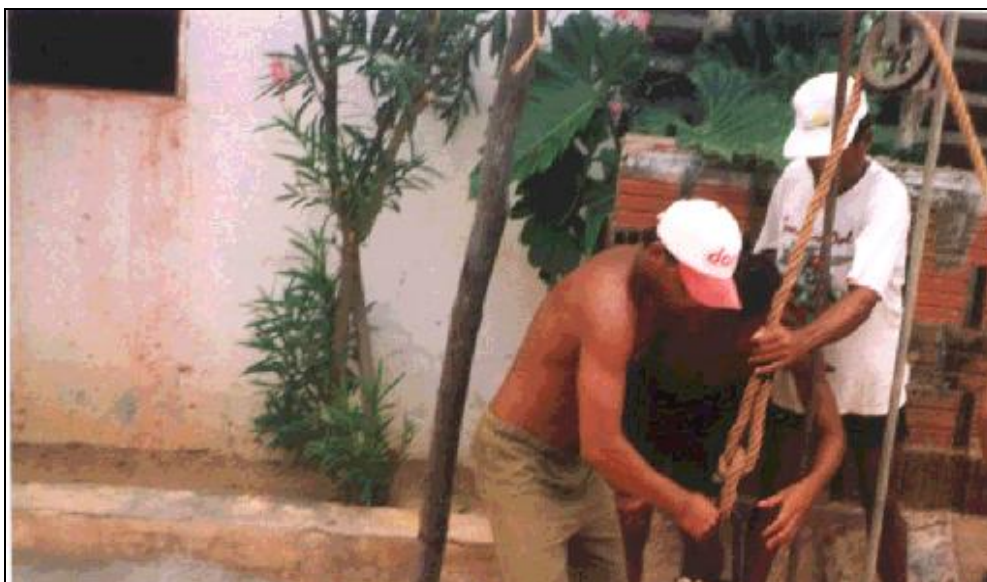
Foto 6 – Aspecto da perfuração de um poço tubular raso pelo processo manual, na zona de recarga do aquífero dunas/paleodunas (localidade da Prainha)
