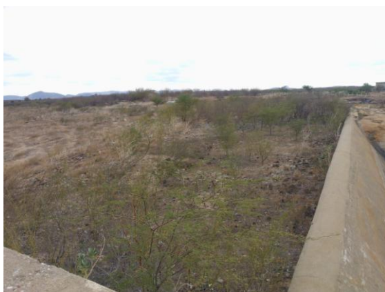
FIGURA 23 - Crescimento de vegetação no canal de aproximação do sangradouro da barragem Caldeirão de Parelhas – RN.
