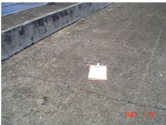
FIGURA 37 - Detalhe de fissura na laje do coroamento próximo à ombreira direita, Barragem Jucazinho – PE, 2004.
