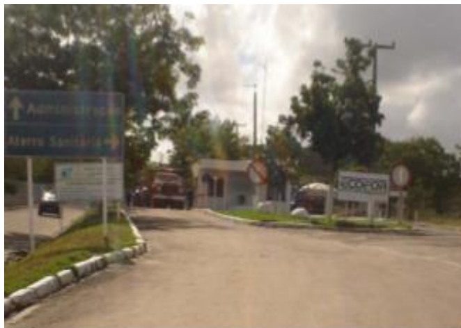
Figura 03: Vista da área de acesso ao ASMOC.
