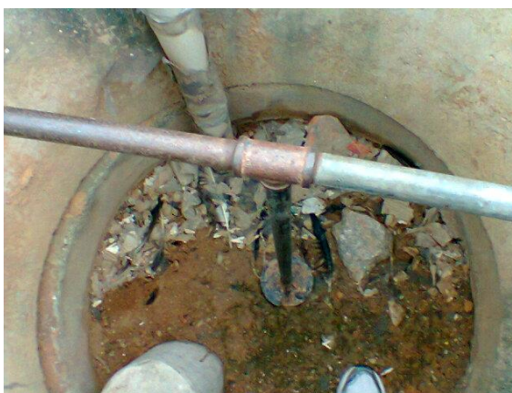
Figura 18 - Remoção da camada superior, pelo trado, para a coleta da massa de resíduos.
